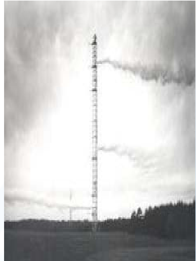
BNL 85 m Met Services tower
